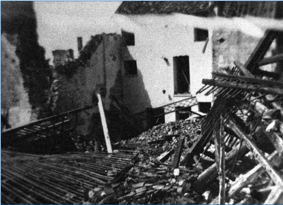
4) Les destructions à Aillant-sur-Tholon.
